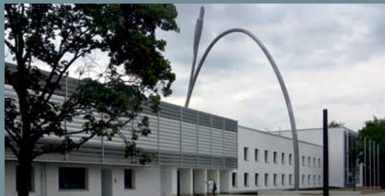
Projektsteuerung: Hauptschule Elisabeth-Kohn-Straße, München © Intep – Integrale Planung GmbH
