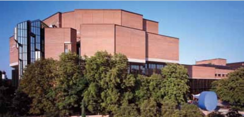
Gasteig München GmbH; Kulturzentrum Gasteig München © Gasteig München GmbH/Barbara Stenzel
