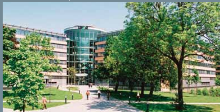
Stadtwerke München; Stadtwerkszentrale © SWM/Stefan Obermeier
