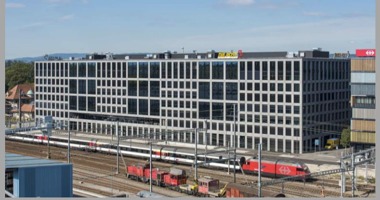
Espace Post, Bern Wankdorf | SNBS Pilotzertifizierung
