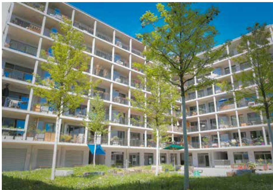
Fast zwei Drittel der Gebäude mit Wohnnutzung werden immer noch fossil beheizt. (BILD: FOTO KULTURPARK)
