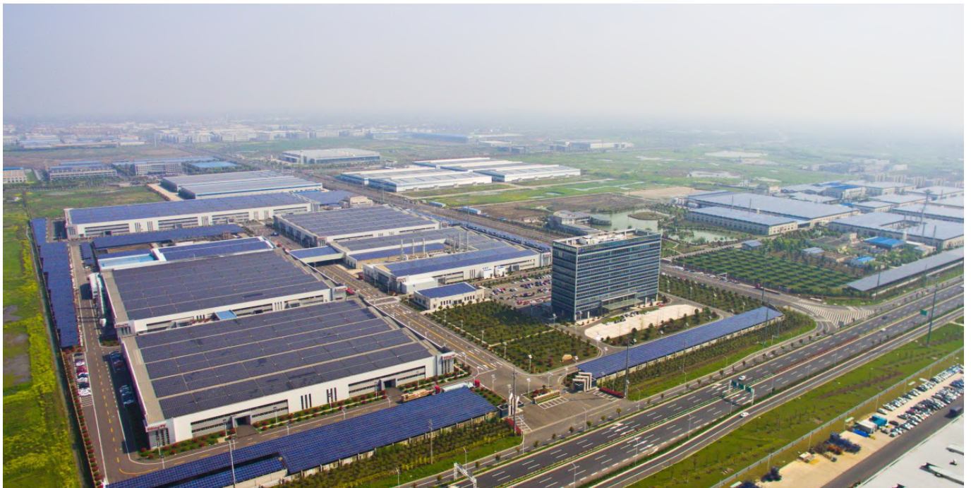
图 1-3 亿晶光电屋顶光伏项目 (3万千瓦) 20
